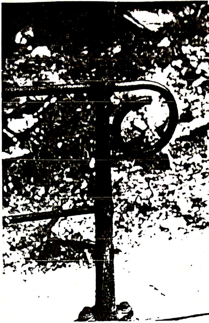
Λεπτομέρεια κιγκλιδώματος γέφυρας
