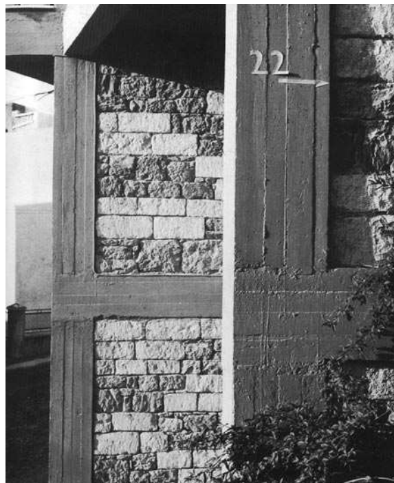
Εικ. 3. Κατοικία Ξύδη, Αθήνα, 1960-61. Λεπτομέρεια.
