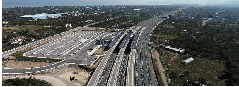
Εικ.13, Σταθμός Αιγίου
