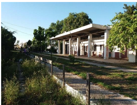
Εικ.10 Σταθμός Κιάτου
