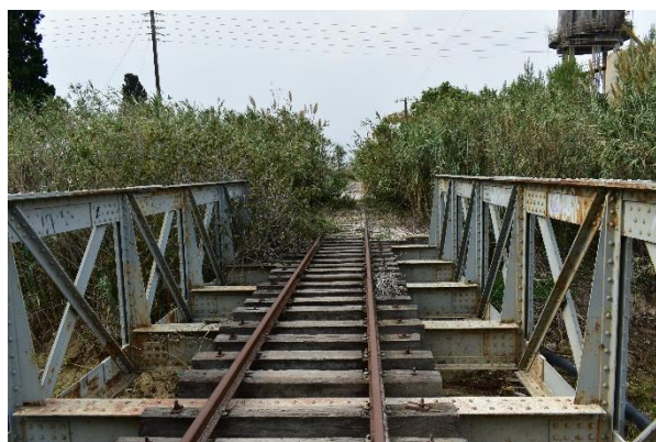
Γέφυρα Κάτω Άσσου
