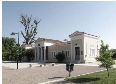
Εικ.15, Σταθμός Αρχαίας Ολυμπίας
