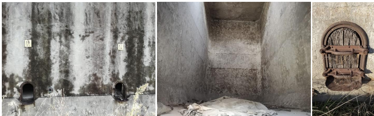
Δεξαμενές. Εξωτερικό, εσωτερικό, πορτάκι.
