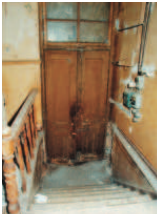
Εσωτερικό πόρτας εισόδου και σκάλα ανόδου της καπναποθήκης Ηλίου
