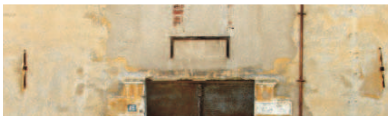
Σίδερα που υπάρχουν και δείχνουν στις όψεις τις θέσεις των πατωμάτων του κτιρίου της καπναποθήκης ΣΕΚΕ.
