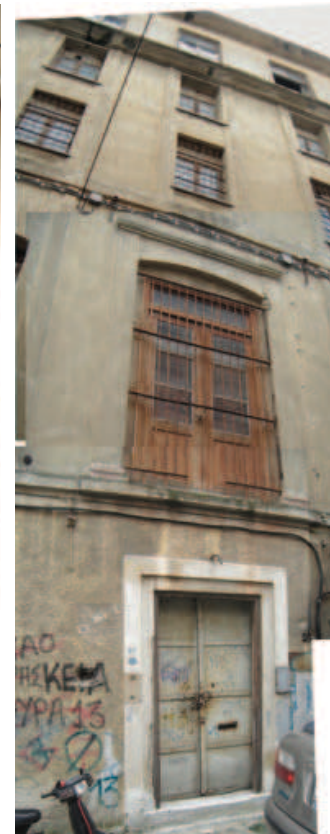
Είσοδος καπναποθήκης, οδού Δαμιανού 23Α
