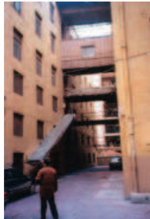
Άποψη της σύνδεσης των δύο καπναποθηκών.
