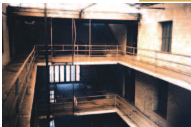
Αερογέφυρα και διάδρομοι στο κέντρο που ενώνει τα δύο τμήματα της καπναποθήκης (πηγή διαδίκτυο)
