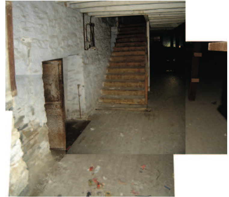
Εσωτερική άποψη καπναποθηκών.
