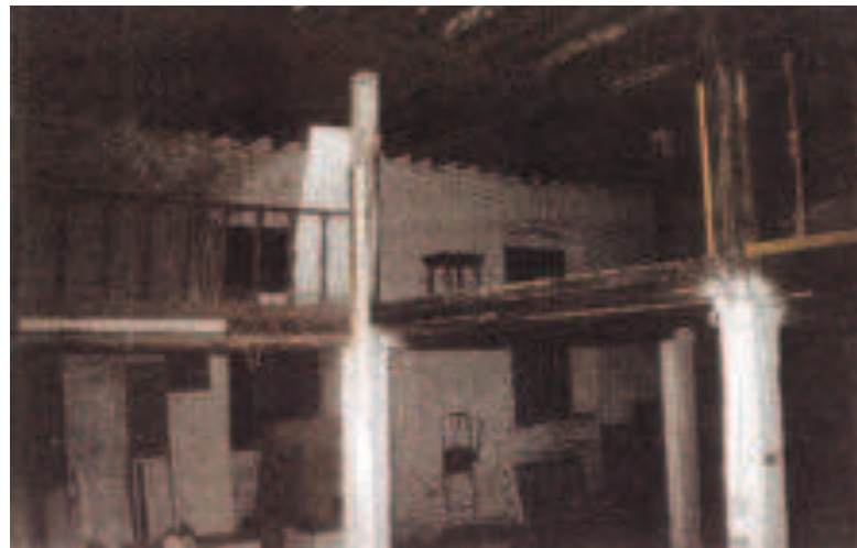
Άποψη εσωτερικού κα- πναποθήκης ισόγειο και μεσοπάτωμα (αρχείο Γ.Αναγνωστόπουλου)
