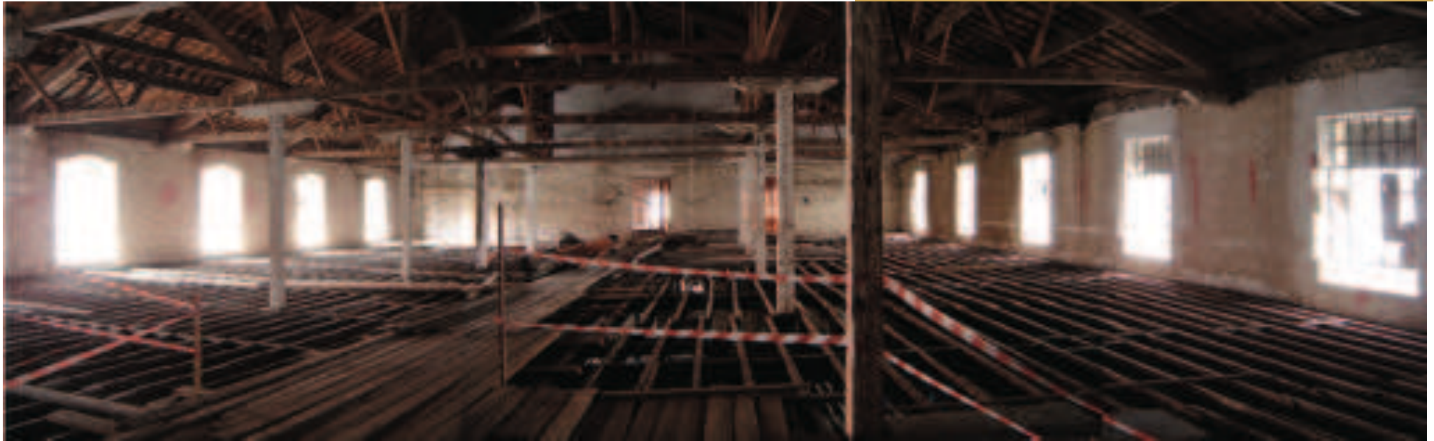
Γενική άποψη ορόφου καπναποθήκης.
