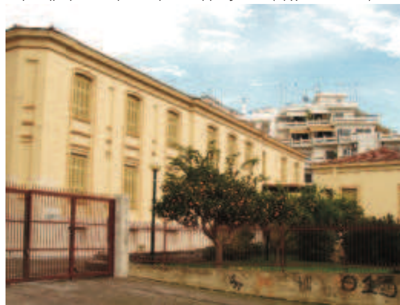
Κατακόρυφες ταινίες διατρέχουν το κτίριο πλαισιώνοντας τα ανοίγματα, καπναποθήκη Παπαστράτου στο Αγρίνιο (αρχείο συντακτριών)
