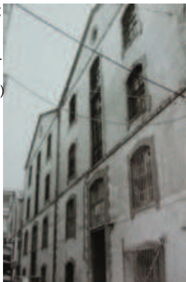
Καπναποθήκες (3) Αναγεννήσεως 4, ιδιοκτησίας Γ.Γεωργίου (αριστερά), (2 όμοιες) σε οδό β' πάροδο Αναγεννήσεως ιδιοκτησίας Ισραηλιτικής κοινότητας Καβάλας (κέντρο), και ιδιοκτησίας Αχ.Αναστασιάδη (δεξιά), (αρχείο συντακτριών)
