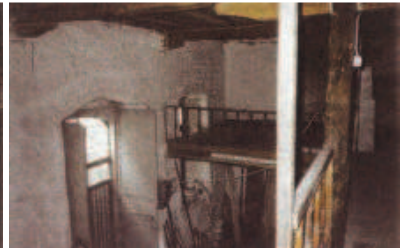
Άποψη εσωτερικού της καπναποθήκης ισόγειο και μεσοπάτωμα (αρχείο Γ.Αναγνωστόπουλου)
