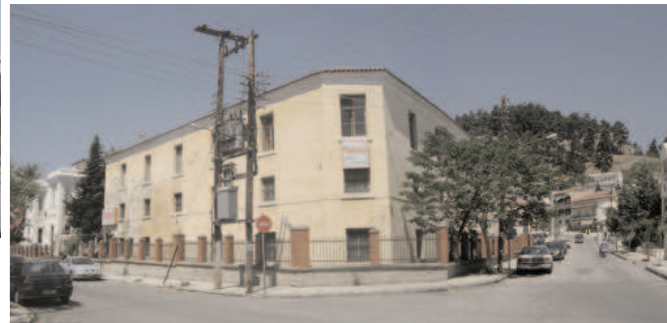
Καπναποθήκη (άποψη από οδό Ορφέως)
