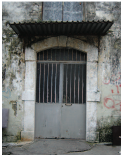
Καπναποθήκες (3 όμοιες) β' πάροδου Αναγεννήσεως, ιδιοκτησίας Αχ.Αναστασιάδη (Αρχείο συντακτριών)
