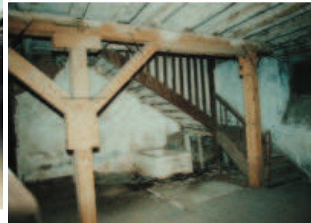
Ξύλινη σκάλα ανόδου από υπόγειο σε όροφο και υποστηλώματα οροφής
