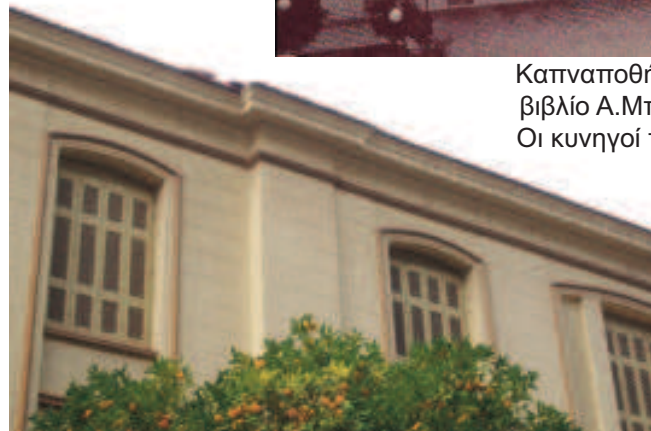
Σύνδεση παλαιότερου και μικρότερου κτίσματος με νεώτερου και ογκωδέστερου καπναποθήκης Παπαστράτου σε οδό Δεληγιώργη
