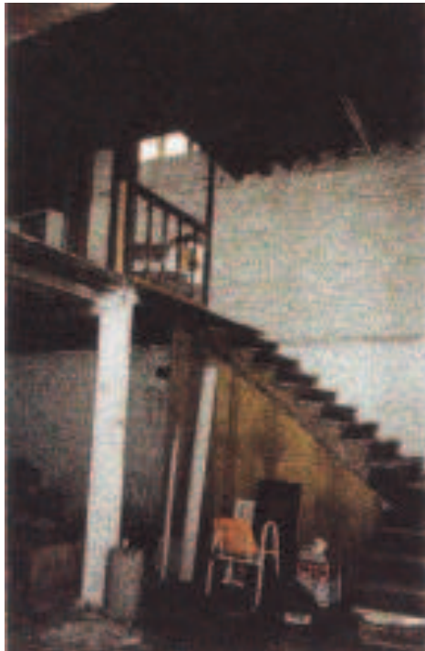
Ξύλινο κλιμακοστάσιο ισογείου προς μεσο- πάτωμα (αρχείο Γ.Αναγνωστόπουλου)
