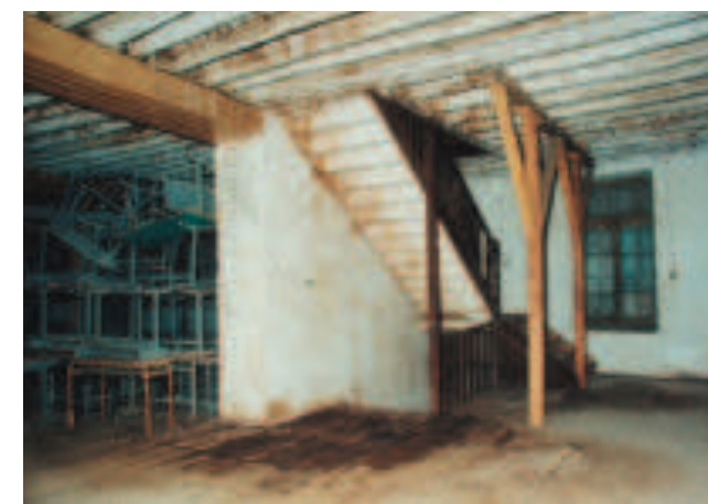
Μερική άποψη ξύλινης σκάλας ανόδου από υπόγειο σε όροφο και υποστηλώματα οροφής
