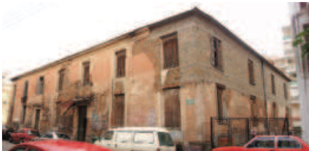
Νότια και δυτική οψη της καπναποθήκης Ηλιού
