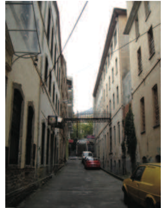
Σύνδεση μέσω αερογέφυρας καπναποθηκών οδού Νίκης 9 με Δαμιανού 23Α
