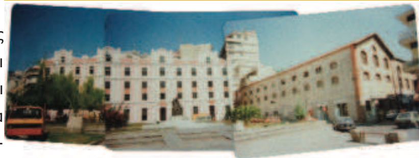
Δημοτική καπναποθήκη και Καπναποθήκη Οθωμανικού μονοπωλίου. (αρχείο Υπουργείου Πολιτισμού, Διεύθυνση Νεώτερης και Σύγχρονης Αρχιτεκτονικής Κληρονομιάς 18/9/91)
