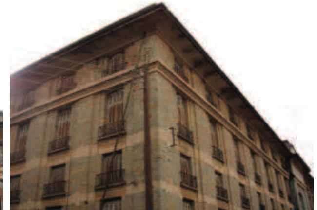
Λεπτομέρεια γείσου και περιμετρικής κορνίζας καπναποθήκης Παπαπέτρου
