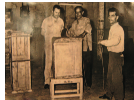
Δεματοποίηση σε ξύλινη πρέσα, (αρχείο Μουσείου καπνού Καβάλας)
