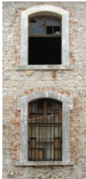
Η διαμόρφωση πλαισίων στα παράθυρα από πλίνθους και πατητό κονίαμα στην καπναποθήκη Μαργαριτοπούλου Ξάνθη (αρχείο συντακτριών)
