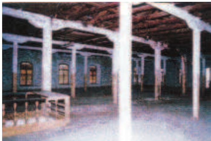
Άποψη β' ορόφου (προς ανατολική και νότια όψη), διακρίνεται η απόληξη του κλιμακοστασίου
