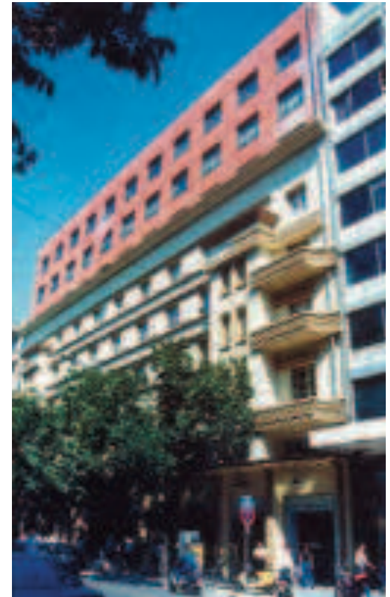
Πρόσοψη μετά την αποκατάσταση.
