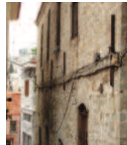
Άποψη πλάγιας πλευράς, περιμετρικά μεταλλικές ενισχύσεις (ελκυστήρες) για το δέσιμο της τοιχοποιίας
