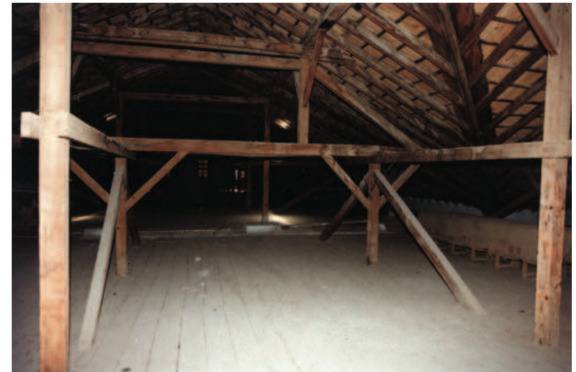
Άποψη της σοφίτας πριν την αποκατάσταση. (αρχείο ΔΗ.Κ.Ι.)
