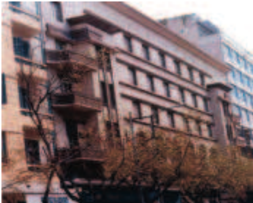
Όψη από την οδό Τσιμισκή πριν την αποκατάσταση.
