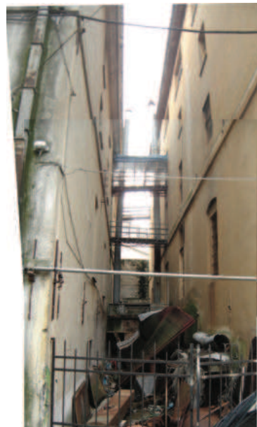
Σύνδεση μέσω αερογέφυρας καπναποθηκών οδού Δαμιανού 21 με 23Α
