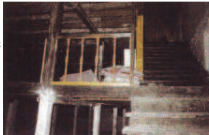
Άποψη κλιμακοστασίου από ισόγειο προς όροφο (αρχείο Γ.Αναγνωστόπουλου)
