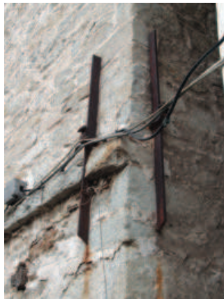
Μεταλλικές ενισχύσεις (ελκυστήρες) για το δέσιμο της τοιχοποιίας
