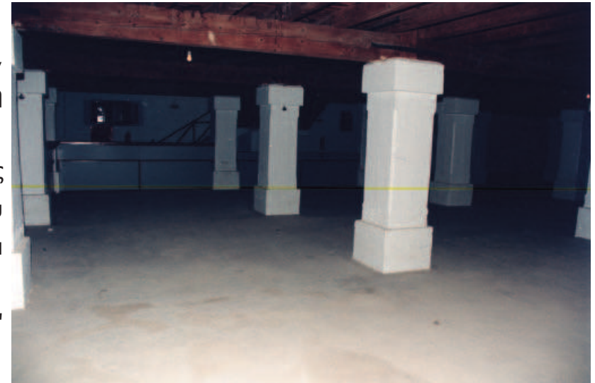
Άποψη του υπογείου πριν την αποκατάσταση. (αρχείο ΔΗ.Κ.Ι.)
