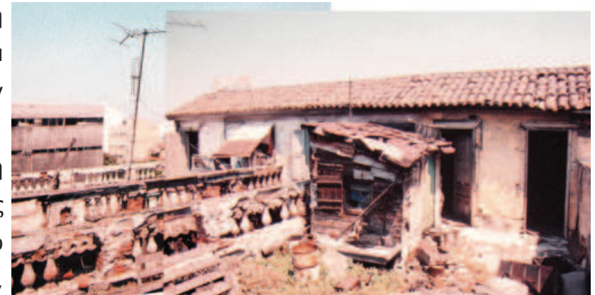
Άποψη βοηθητικών χώρων στο δώμα.(αρχείο Υπουργείου Πολιτισμού, Διεύθυνση Νεότερης και Σύγχρονης Αρχιτεκτονικής Κληρονομιάς, 1987, επεξεργασία συντακτριών)
