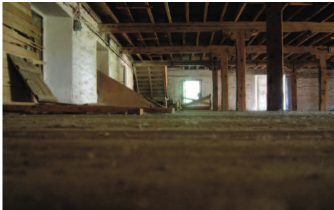
Εσωτερικά χώρος υπογείου.
