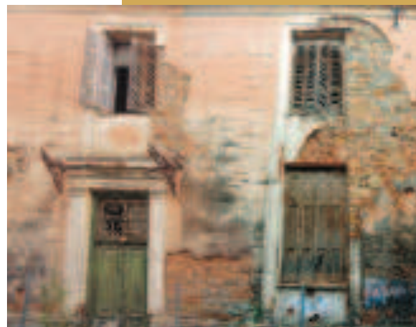
Λεπτομέρεια ανοιγμάτων δυτικής όψης (επί της οδού Μεσολογίου) της καπναποθήκης Ηλιού
