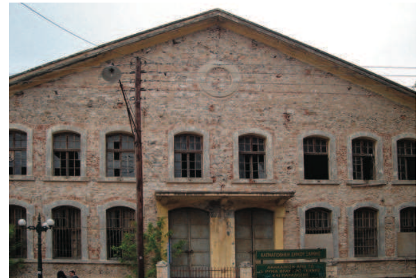
Κύρια όψη (ανατολική) της καπναποθήκης του Οθωμανικού Μονοπώλιου πριν την αποκατάσταση. (αρχείο Α.Βαρβατσούλια)
