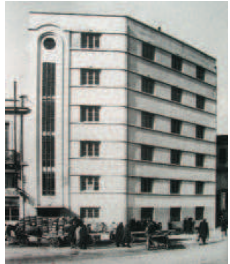
Η καπναποθήκη του Πλ. Γαβριήλογλου επί της οδού Δωδεκανήσου πριν την προσθήκη του 6ου ορόφου. (αρχείο ΕΤΒΑ, βιβλίο "Θεσσαλονίκη 1912-1940, Βιομηχανία και πόλη")
