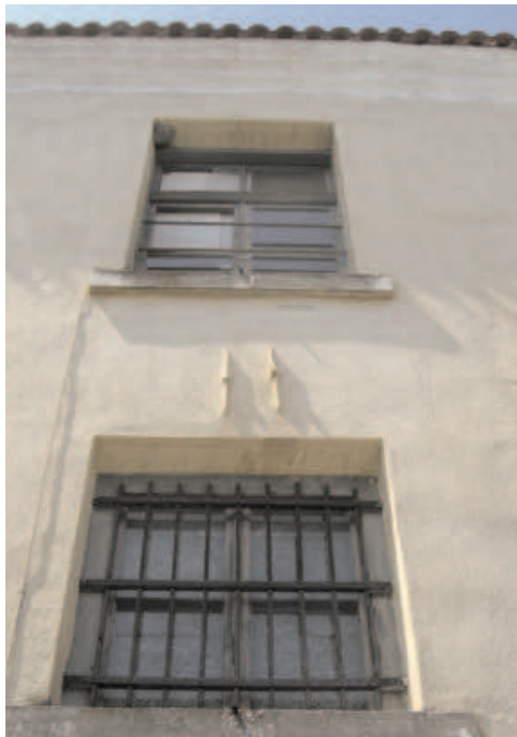
Λεπτομέρειες διαφόρων στοιχείων της καπναποθήκης (σίδερα μεταξύ ορόφων)
