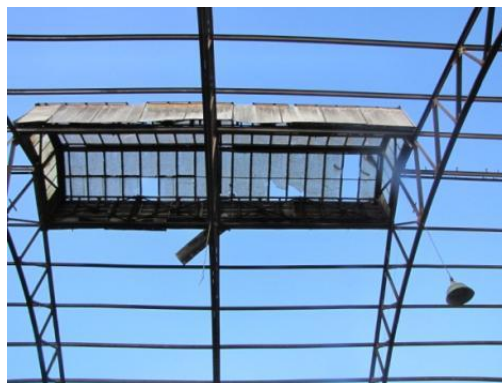
εικ.21 Παρουσίαση υφιστάμενου μεταλλικού φορέα στέγης
