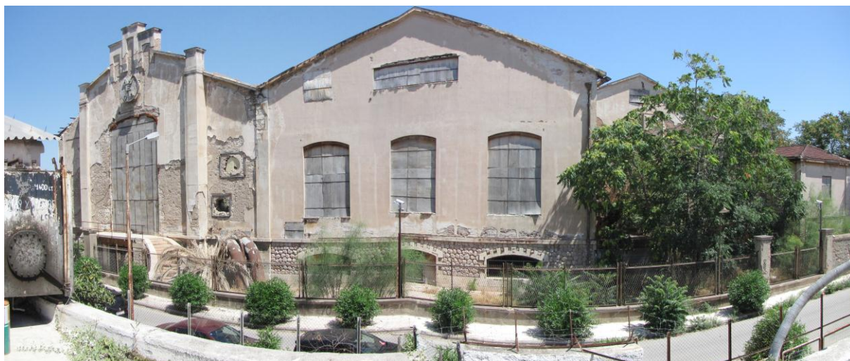
εικ.4 Πανοραμική άποψη της Βόρειας όψης του σταθμού στη σημερινή του κατάσταση.
